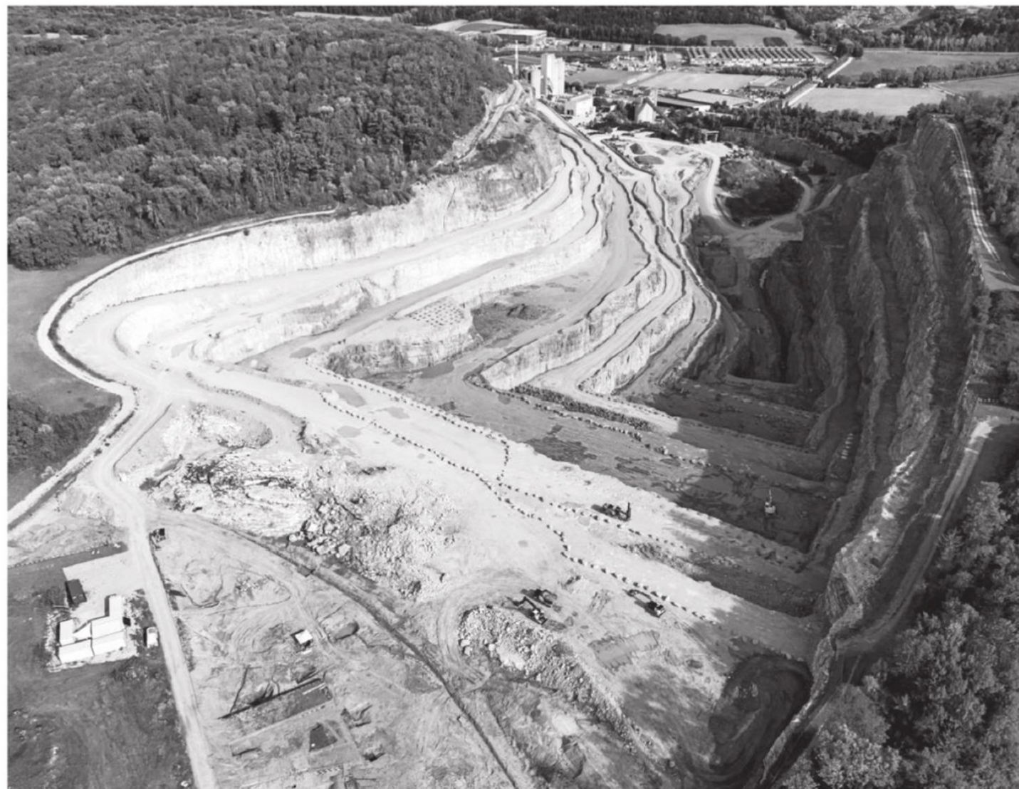
Pour la FAS romande, la colline du Mormont illustre la nécessité de réduire l'usage du béton. KEYSTONE
